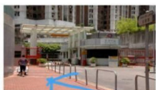
(AB3) 港鐵荃灣車廠門口
